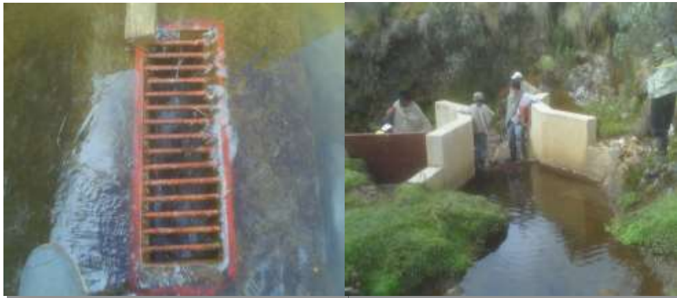
Bocatoma de fondo y Rejilla-Bocatoma de fondo sobre Quebrada Honda.
