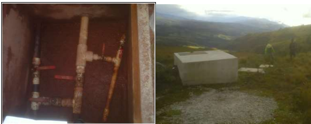
Cámara de bifurcación y Caja de válvulas. Fuente: Acodal, 2009
