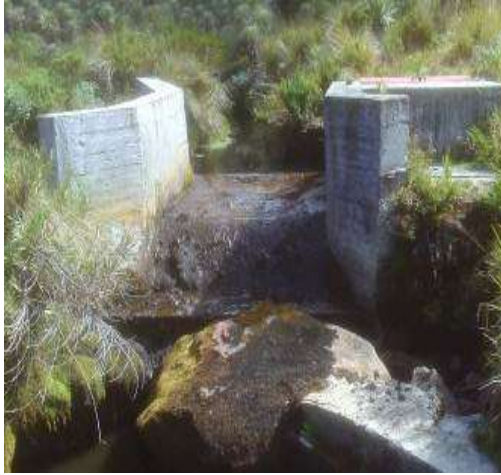
Bocatoma de fondo Quebrada Hoya del Espejo.
