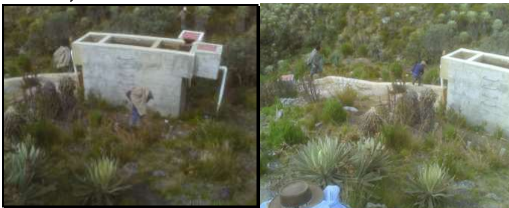
Desarenador tipo convencional en concreto reforzado. Fuente: Acodal.
