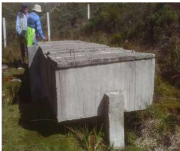
Desarenador tipo convencional en concreto reforzado Aguas Claras.
