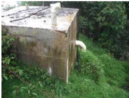
Pozo séptico en funcionamiento
