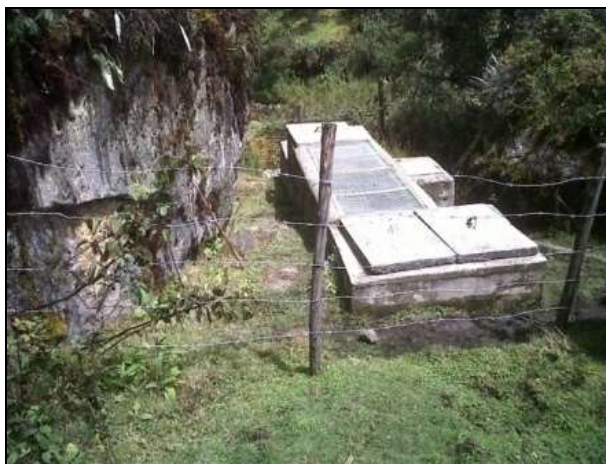
Desarenador existente. Fuente: visita SDHT 2012
