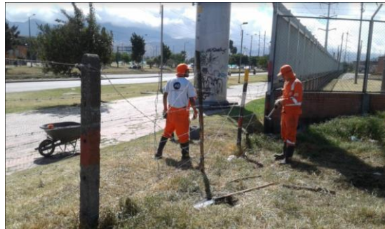
Arreglo de cerramiento provisional
