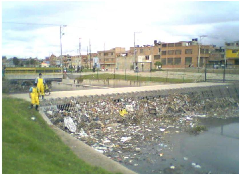
Figura 1. **Rejilla estructura de retención de sólidos Humedal Jaboque.**
