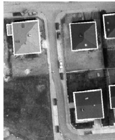
(b) Restitución de techos
