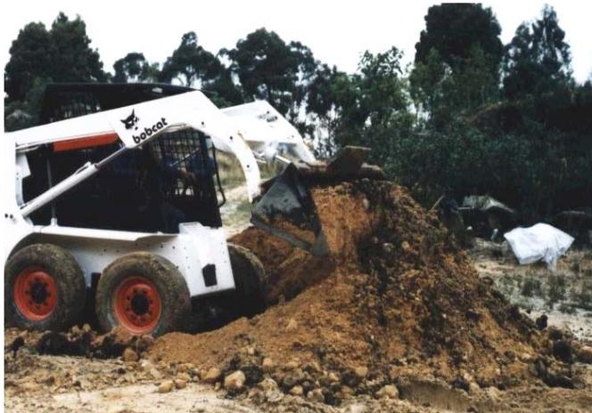
**Figura 9.** Elaboración de las mezclas por medio de un Bobcat
