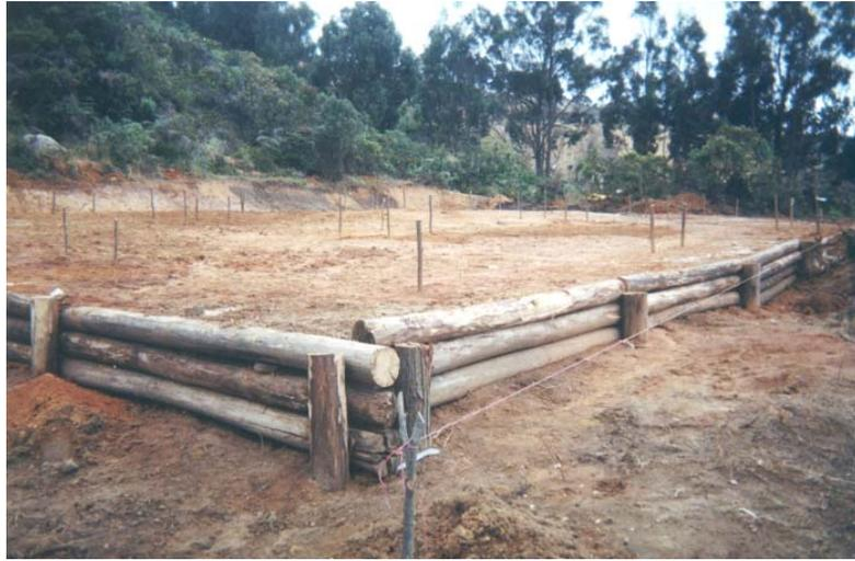
**Figura 7.** Nivelación del terreno y trinchos de contención
