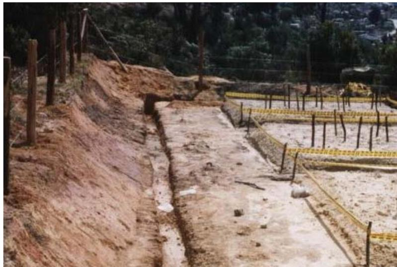
**Figura 5.** Zanjas para la evacuación del agua
