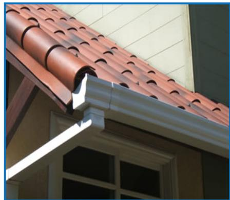
Ilustración 8. Canales para la recolección del agua lluvia (1)
