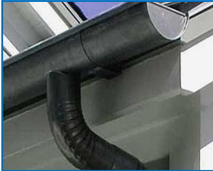
**Ilustración 9.** Canales para la recolección del agua lluvia (2).
