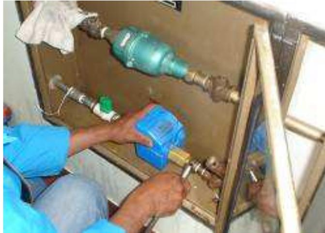
Figura 3.1. Instalación del Medidor Contazara CZ 2000 3M.
