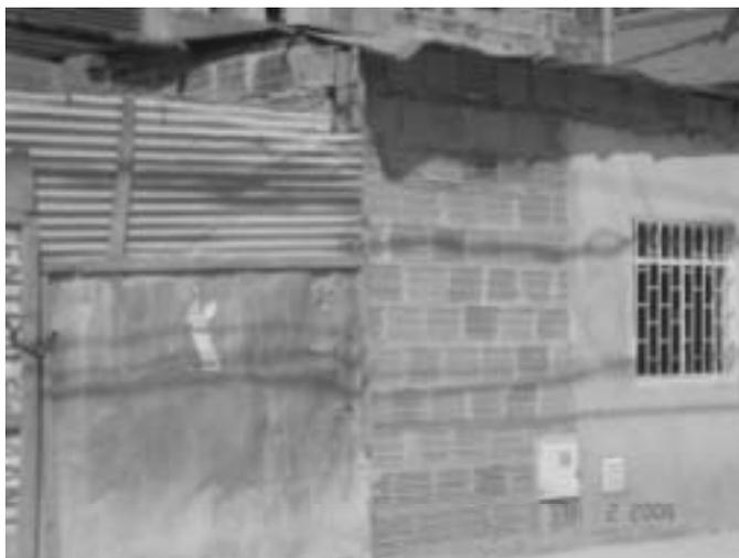
*Imagen 4.2 Ejemplo de viviendas construidas en mampostería no reforzada*
