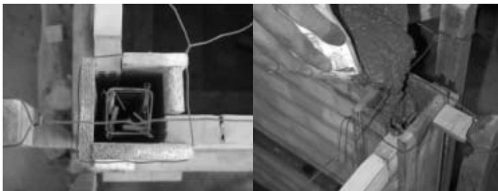
*Imagen 8.15 Vaciado de las Columnas*
