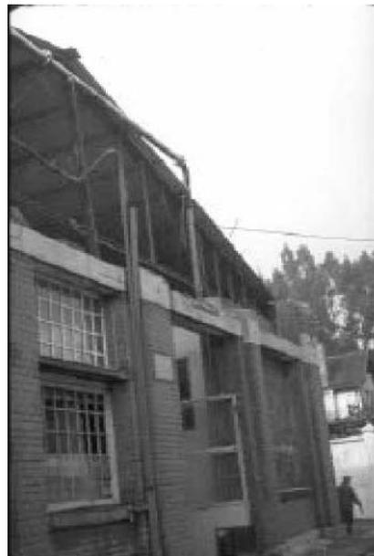
*Imagen 3.1 Izquierda: Fallo fuera del plano de dos muros en el sismo de Loma Prieta
