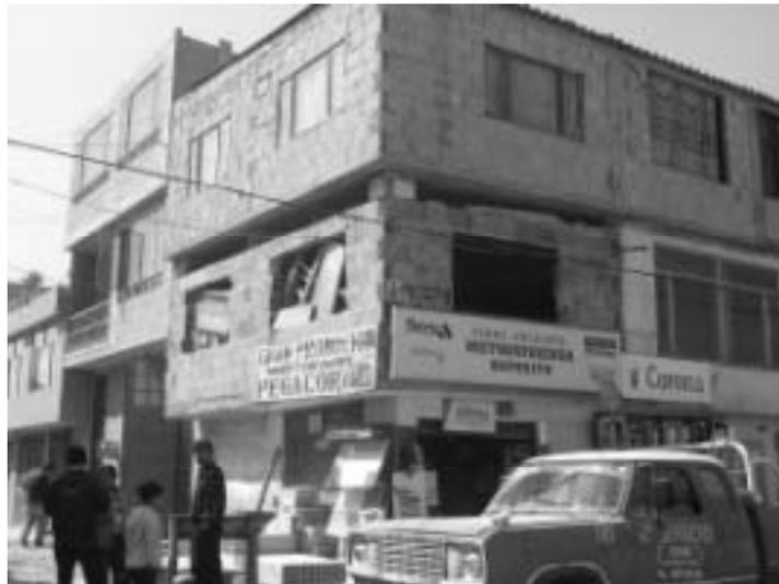
*Imagen 4.4 Ejemplo de Combinación errónea de sistemas en la construcción con mampostería*
