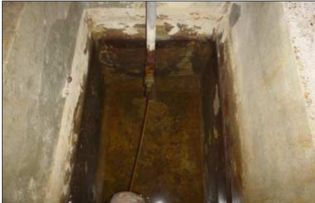
**Imagen 8-1 Tanque de Almacenamiento Subterráneo en mal estado**
