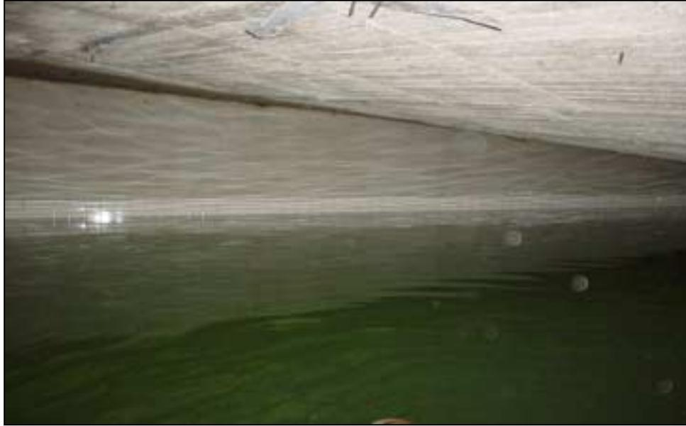
**Imagen 8-6 Estancamiento del Agua por grandes tiempos de retención hidráulica**
