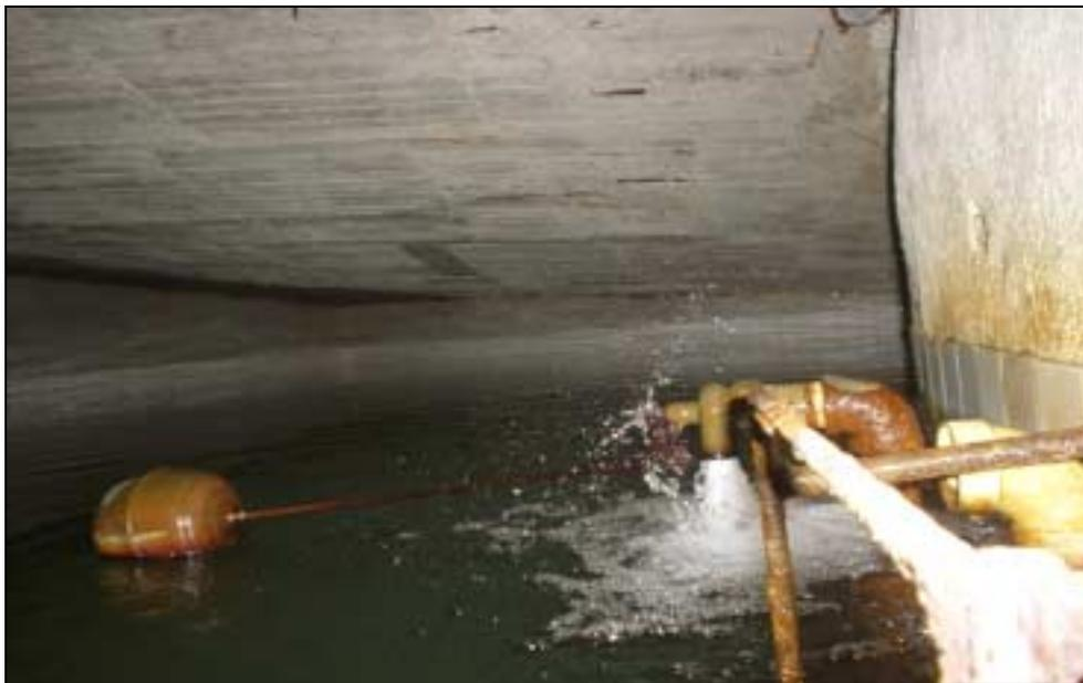
**Imagen 8-4 Sistema de Autorregulación del Tanque - Flotador**
