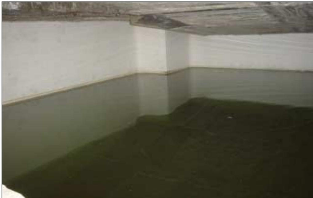
**Imagen 8-2 Tanque de almacenamiento en buen estado**
