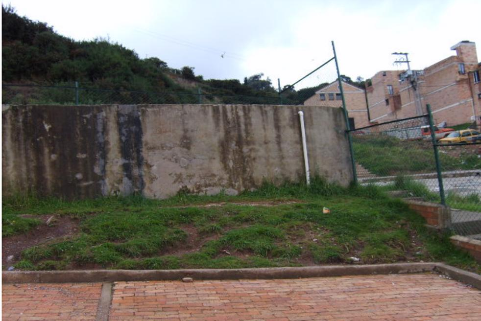
Foto 55. Tanque de abastecimiento en estado de deterioramiento.
