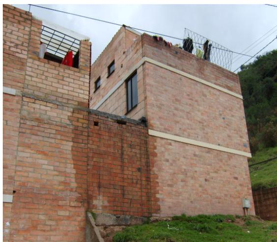
Foto 28. Sistema estructural “Mampostería Parcialmente Reforzada”.
