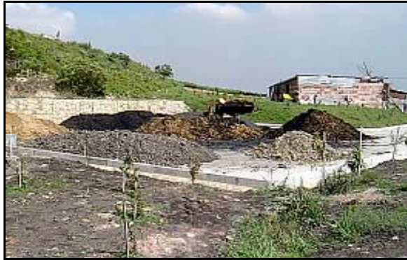
Figura 10. Preparación de las diferentes mezclas en el sitio de acopio.
