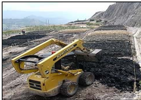
Figura 11. Montaje de las parcelas con la mezcla de biosólidos y estériles, realizada una pala mecánica
