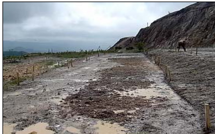
Figura 8. Montaje de las terrazas para la implementación de los bloques
