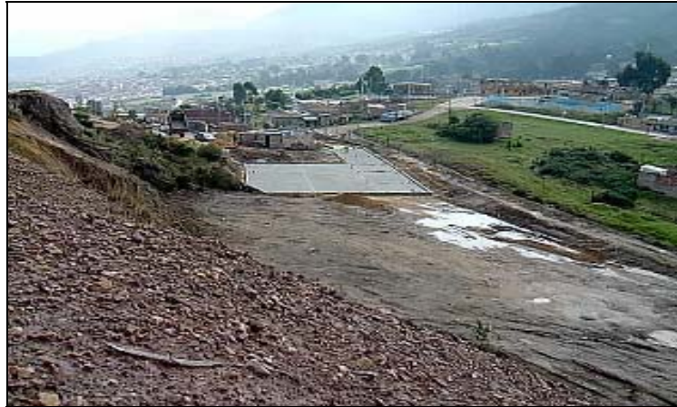
Figura 7. Área previa a la implementación de las terrazas para los bloques
