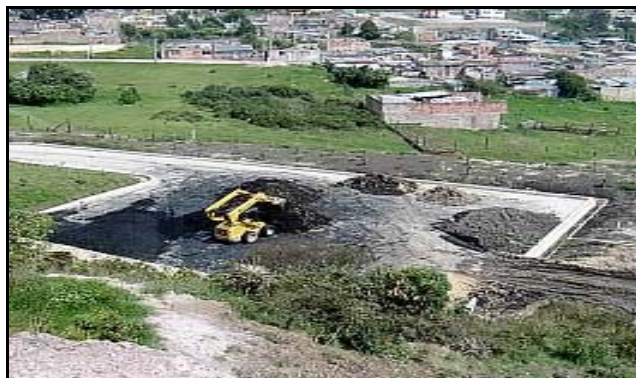
Figura 9. Proceso de mezcla de biosólidos y estériles en el área aledaña al sitio del experimento.
