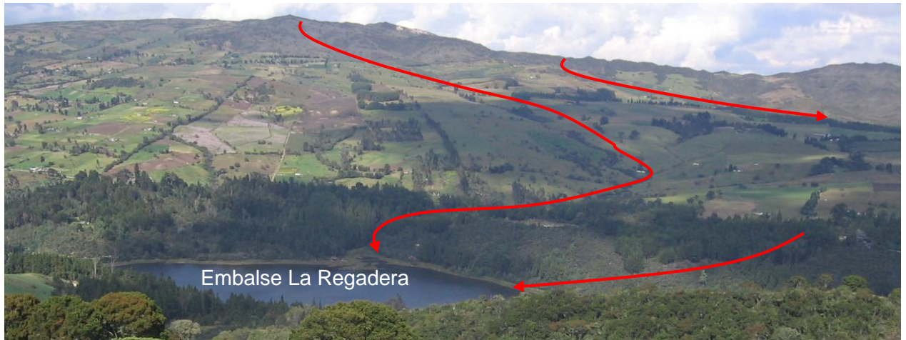
Foto No. 117 Vista panorámica del AFD CR Aguadita La Regadera. Fuente: PMA AFD CR Aguadita La Regadera, 2010.
