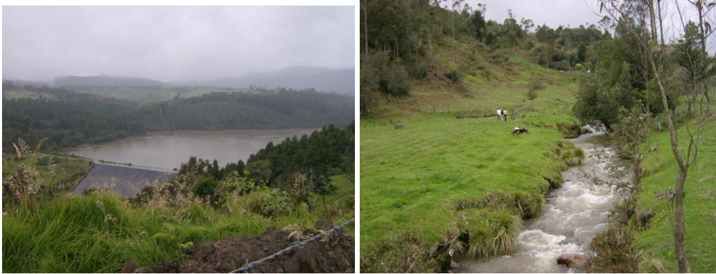
Foto No. 130 y 131 Panorámica del PEDM La Regadera
