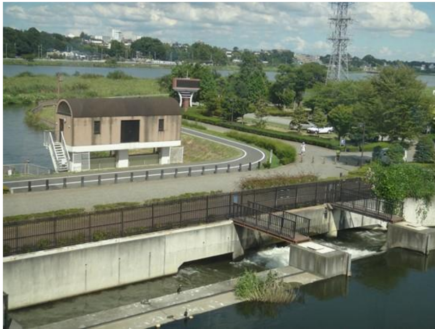
PLANTA DE BOMBEO INYECCIÓN DE AGUA DE LOS RÍOS OHORI Y SAKA PARA MEJORAR CALIDAD DEL AGUA DEL LAGO TEGANUMA
