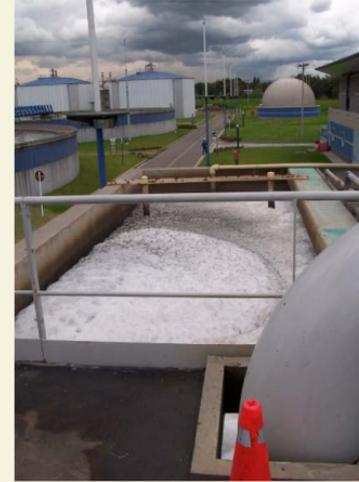
En la primera fase del proceso se eliminan los sólidos suspendidos del agua residual pero no se pueden eliminar las espumas de los detergentes no biodegradables. Con pautas de consumo ambientalmente sano, se facilitaría el proceso de tratamiento.
