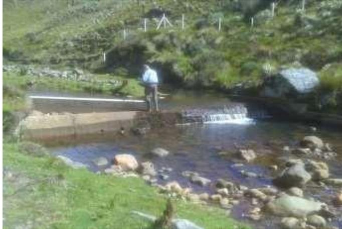
**Bocatoma de Fondo:** Construida en concreto reforzado en el año 1999, actualmente se encuentra en buen estado. Los elementos que componen la bocatoma son los siguientes: muro transversal en concreto reforzado, aleta de encauzamiento en concreto reforzado, muro paralelo a roca natural en concreto reforzado, rejilla rectangular en hierro de 0.76 cm x 0.36 cm con 25 varillas de ½", aducción al desarenador tubería en PVC diámetro de 4"
