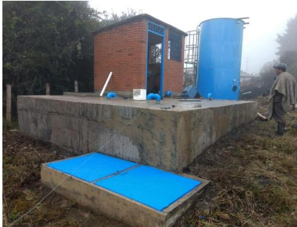
**Tanque de Almacenamiento:** Tanque semienterrado en concreto reforzado, ubicado a 3412 m.s.n.m., latitud 4°11'56.7" longitud 74°09'10.2" (Norte 956086.874 - Este 991637.169), de compartimiento simple, cubierto mediante una placa maciza del mismo material, sus dimensiones son: 5.88 m de ancho, 34.88 m de largo, profundidad de 2.14 m (borde de libre de 0,20m), y espesor de paredes de 23 cm a lo largo de la longitud del perímetro.
