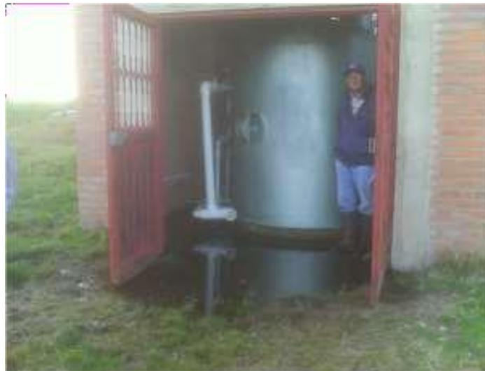
**Tanque de Almacenamiento:** Construido en concreto reforzado. Esta construido debajo de una caseta prefabricada, y está enterrado por lo cual se dificulta la inspección visual de fisuras, desprendimiento de pañete, grietas y en general algún tipo de daño en la estructura. Dentro de la caseta se encuentra un tanque que contiene el cloro.
