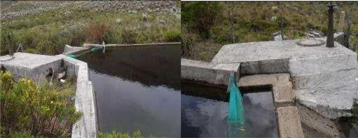
**Aducción:** La aducción del agua cruda captada por la bocatoma hasta la estructura de pre desarenador, es realizada por medio de una tubería construida en PVC de 4". La cual se encuentra suspendida en estructuras.
