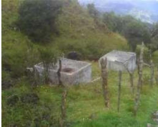
**Desarenador Acueducto Jericó:** Está constituido por una estructura de concreto con las siguientes dimensiones largo 3.15 m, base 2.0 m y profundidad 1.93 m y espesor de 0.05m. Tiene tres baffles transversales, hasta una profundidad de 1.06 m. La salida es un orificio de 4", centrado en el ancho del último baffle y muy cerca del fondo de la caja de salida. Se realiza mantenimiento cada mes. Entrada caja desarenadora Acueducto Jericó
