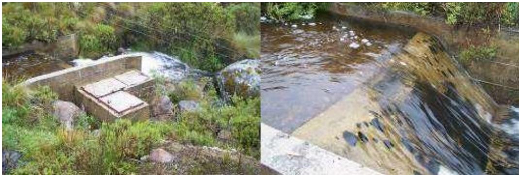
**Línea de Aducción:** La aducción del agua cruda captada por la bocatoma hasta la estructura de desarenador, es realizada por medio de una tubería construida en PVC de 4”.
