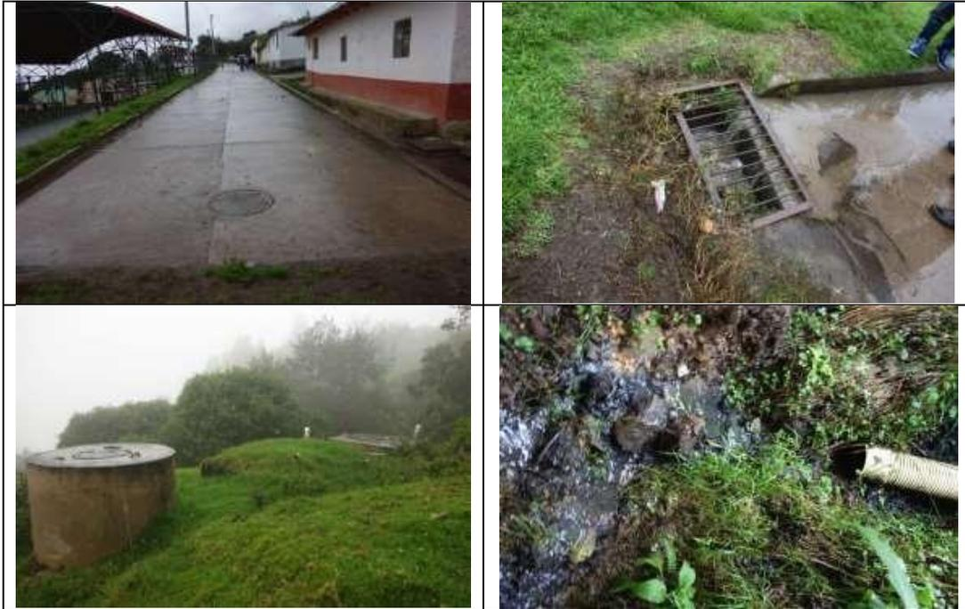
No existe Planta de tratamiento para aguas residuales, sin embargo, se encontraron dos pozos sépticos de las siguientes dimensiones  $3,70 \times 2,20 \times 1,70$  el cual no está en funcionamiento y otro de  $2,40 \times 2,34 \times 2,65$  que trata las aguas de un sector del centro poblado.
