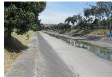
Fotografía 2. Aguas abajo del Inicio de canal San Francisco en la localidad de Fonitbon sobre la Av. 68.
