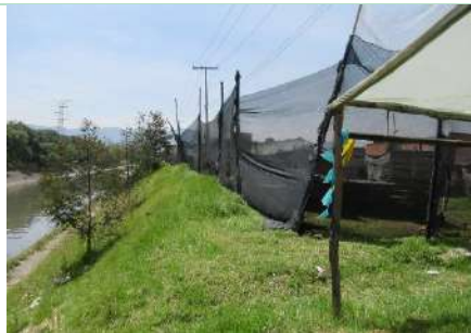
Fotografía 19. Invasión del área de ronda del canal San Francisco por consolidaciones de manpostería del establecimiento denominado Parqueadero El Terminal.
