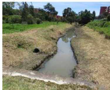
Fotografía 20. Canal Hayuelos aguas arriba de su desembocadura en la estructura de concreto tipo Box Culvert que desemboca en el canal San Antonio.
