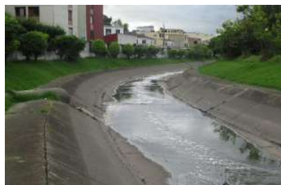
Fotografía 18. Vertimiento sobre el margen izquierdo del canal por parte de una Estructura de Red Pluvial ubicada en la AV 86-23ABIS 67, con diametro de tubería 32" en concreto sin Refuerzo.
