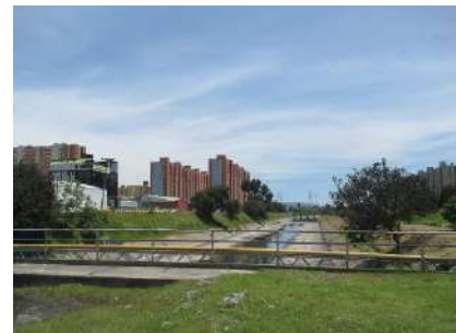
Fotografía 53: Invasión del corredor ambiental de ronda sobre el margen izquierdo del canal aguas debajo de la Intersección con la Av. Calle 17
