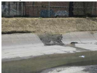
Fotografía 56: Fractura del canal en el margen izquierdo del canal aguas debajo de la Intersección con la Av. Calle 17.
