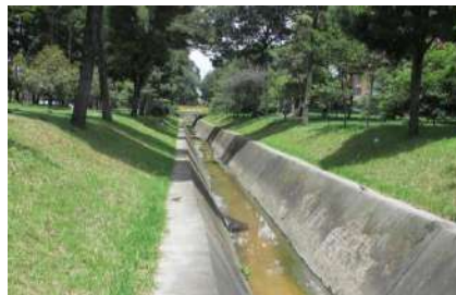
Fotografía 4. Canal Hayuelos seccion trapezoidal del inicio del canal hasta la Carrera 88A
