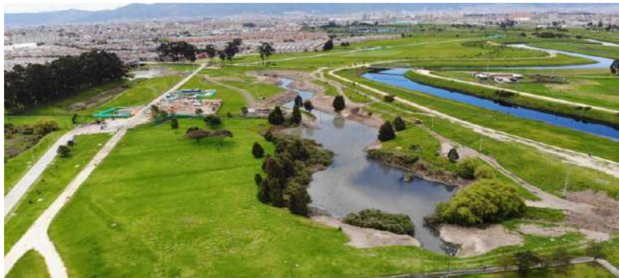
Imagen 15: Estación de bombeo y pondaje La Rivera en la localidad de Fontibón.
