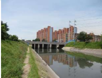
Fotografía 48: Canal San Francisco antes del paso sobre la Calle 19 A
