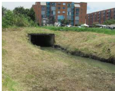
Fotografía 19. Canal Hayuelos entrega de aguas a estructura de concreto tipo Box Culvert que desemboca en el canal San Antonio.
