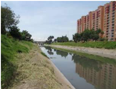
Fotografía 50: Mantenimiento franja terrestre margen izquierdo del canal antes de la Av. Calle 17
