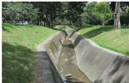
Fotografía 3. Aguas abajo del inicio de canal Hayuelos, seccion trapezoidal del canal
