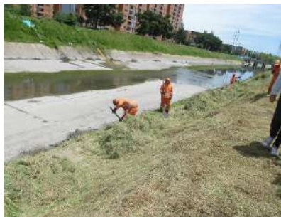
Fotografía 52: Intersección del canal con la Av. Calle 17
