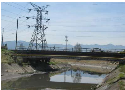
Fotografía 9. Canal San Francisco aguas debajo de la Av 68D Cll 22.
