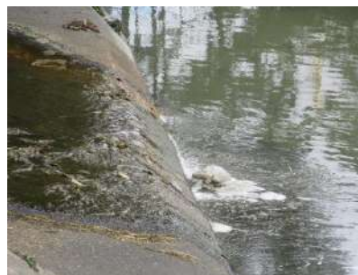
Fotografía 20. Confluencia del canal Boyaca con el canal San Francisco, el flujo de agua denota características de agua residual doméstica en virtud de las espumas y olores ofensivos perceptibles a la distancia, situación que se presenta por la existencia de conexiones erradas aguas arriba.
