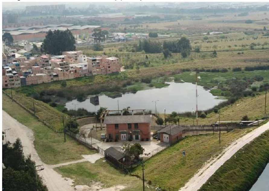
Imagen 16: Estación de bombeo y pondaje La Rivera en la localidad de Fontibón.
