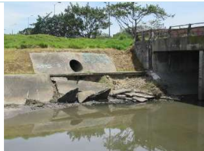
Fotografía 33: Presencia de Retamo espinoso (Ulex europaeus) en el margen norte del canal sobre el canal entre las calles 72c y 72d bis
