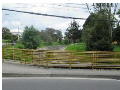
Fotografía 12. Canal Boyaca aguas abajo del cruce vehicular de la Av. Esperanza
