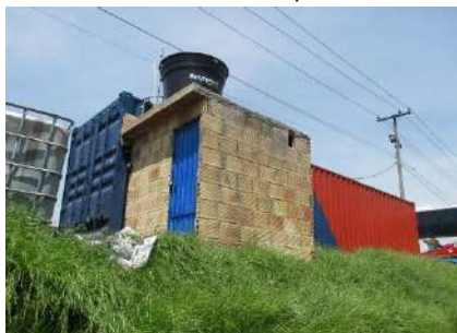
Fotografía 21. Casetas sobre el área de ronda del canal San Francisco ubicadas dentro del establecimiento denominado Parqueadero El Terminal.
