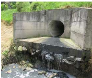
Fotografía 17. Colector de la red local pluvial que presenta vertimiento al canal de coordenadas 4°40'04.3"N 74°08'11.8"W (4.667860 / -74.136622)
