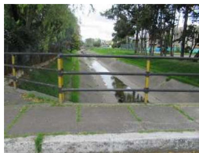
Fotografía 20. Confluencia del canal Boyaca con el canal San Francisco, el flujo de agua denota características de agua residual doméstica en virtud de las espumas y olores ofensivos perceptibles a la distancia, situación que se presenta por la existencia de conexiones erradas aguas arriba.
