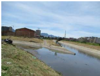
Fotografía 62: Entrega de aguas del canal San Francisco al Río Fucha
