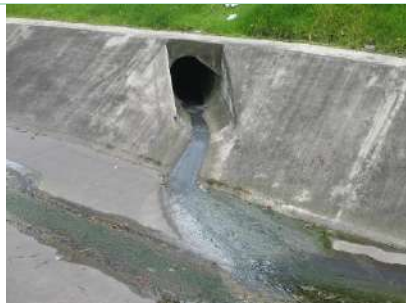
Fotografía 9. Canal Boyaca a la altura del Puente peatonal de la Av. Esperanza
