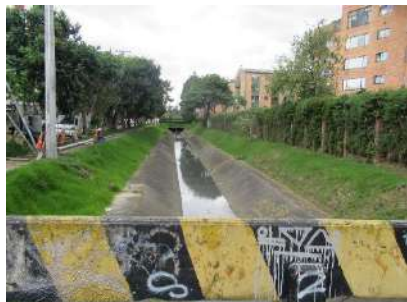
Fotografía 9. Canal Complementario aguas abajo del puente vehicular de la Calle 24C
