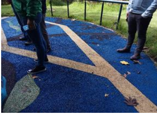
Desprendimiento del material sintético instalado en las plazoletas. Visita de campo realizada al humedal de Santa María del Lago el día 30/06/2022.
