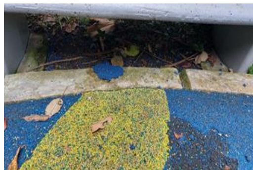
Desprendimiento del material sintético instalado en las plazoletas. Visita de campo realizada al humedal de Santa María del Lago el día 26/04/2022.
