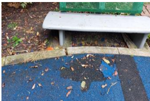
Desprendimiento del material sintético instalado en las plazoletas. Visita de campo realizada al humedal de Santa María del Lago el día 18/04/2022
