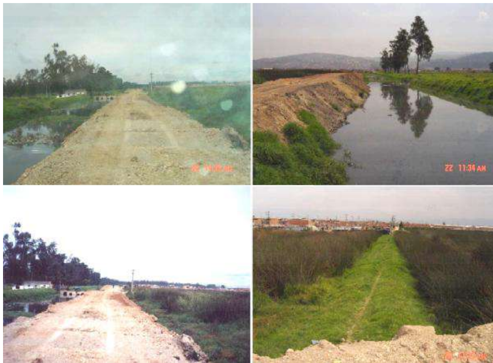
Figura II-23. Vista del jarillón paralelo al canal Tibanica y el sendero que atraviesa el humedal, registro fotográfico de diciembre 2004.
