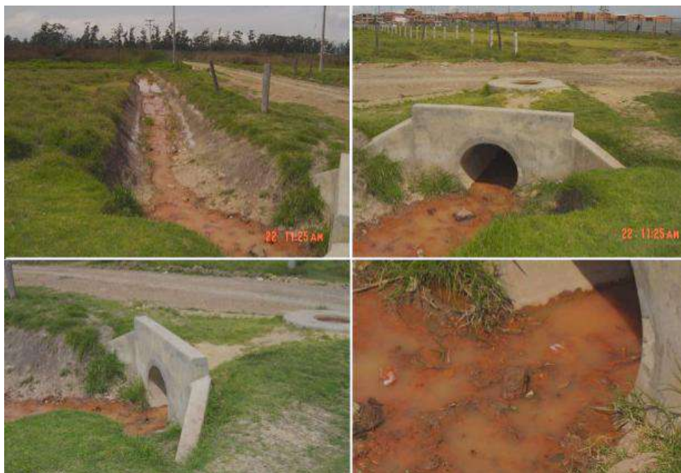
Figura II-22. Obra para drenar aguas lluvias al borde de la carretera que parte en dos al Humedal Tibanica. Imagen tomada en diciembre 2004.
