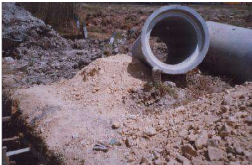
Figura II-21. Tubería para la entrada de aguas lluvias al humedal provenientes de la urbanización Alamedas del Parque, tomada en abril 2005.
