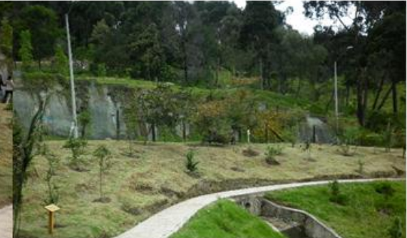
Sector 3 de la quebrada las Delicias costado sur luego de las labores de mantenimiento
