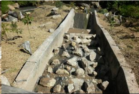
Recolección de residuos sólidos en canal
