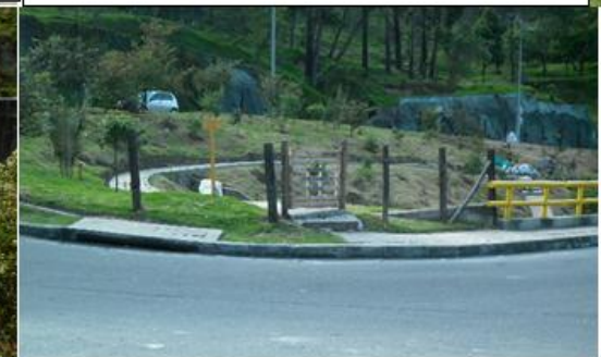
Mantenimiento en el sector 3 de la quebrada las Delicias
