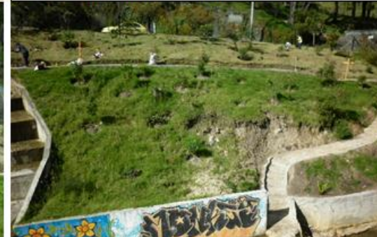
Antes del mantenimiento en el sector 3 de la quebrada las Delicias costado sur
