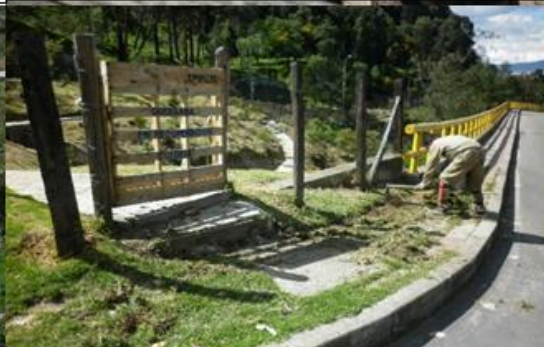
Áreas del sector 3 de la quebrada las Delicias en proceso de mantenimiento
