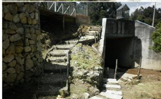
Paso bajo puente luego de las labores de mantenimiento en el paso bajo puente
