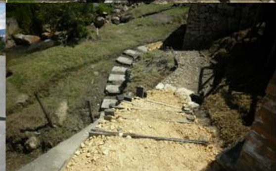
Panorámica de un área luego del proceso de mantenimiento
