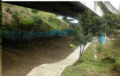
Mantenimiento sendero y ronda sector 3
