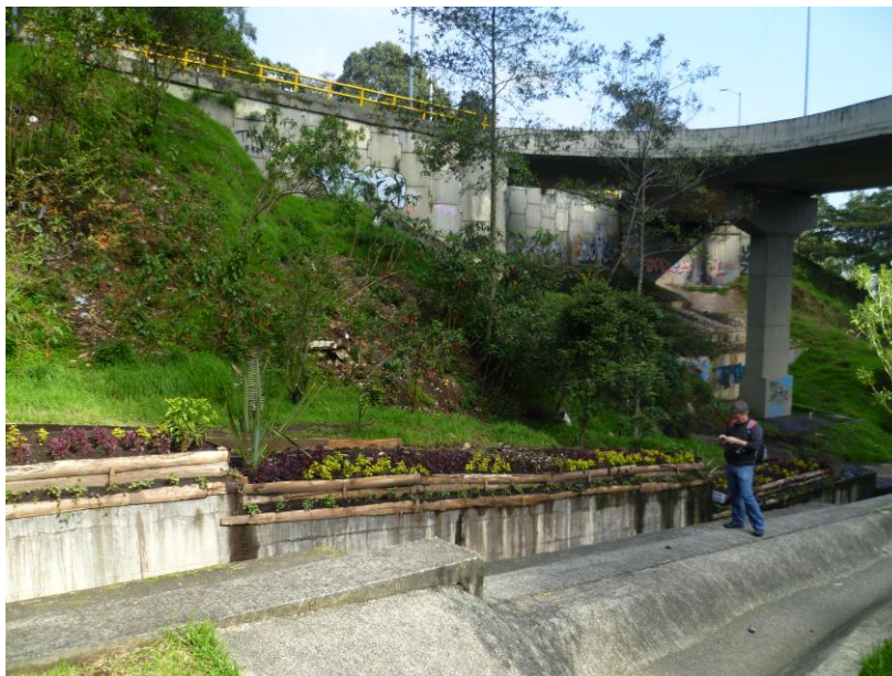
Figura 12. Construcción de la jardinería
