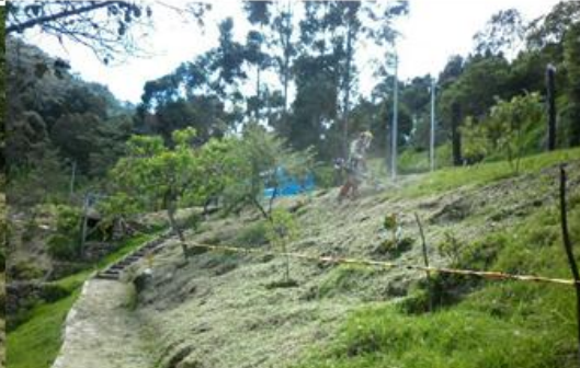
Aislamiento de áreas en el proceso de mantenimiento
