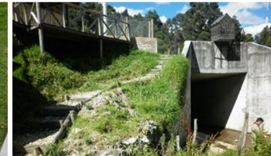
Antes del mantenimiento en el paso bajo puente
