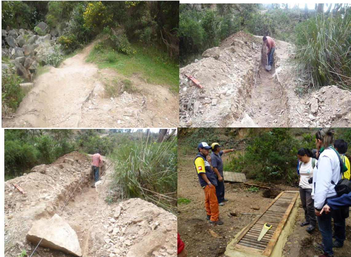
Figura 4. Proceso constructivo de la canaleta para conducción de escorrentías
