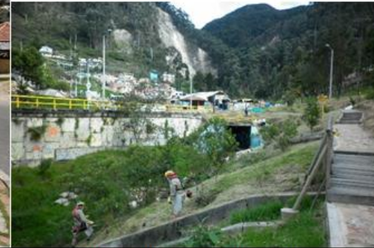
Operarios durante el proceso de mantenimiento
