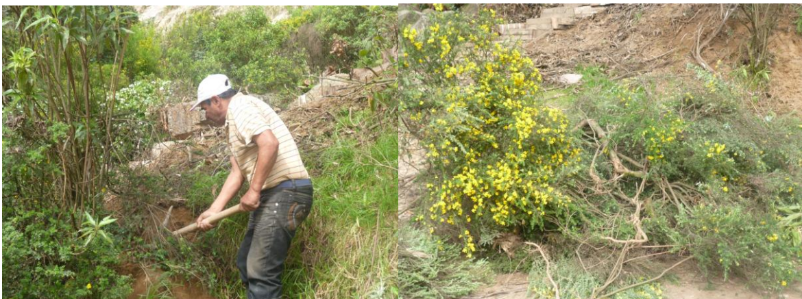
Figura 6. Apertura del camino y eliminación de retamo
