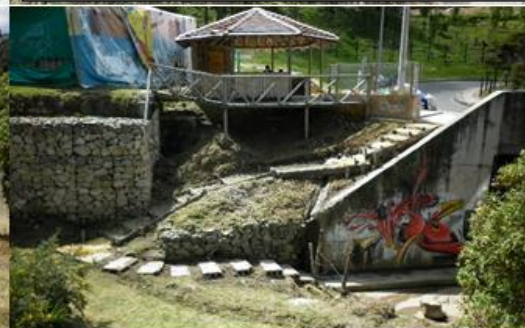
Paso bajo puente luego de las labores de mantenimiento
