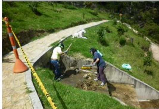
Área aisladas en proceso de mantenimiento
