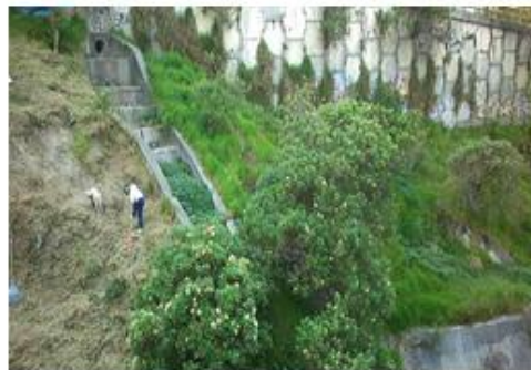
Limpieza de desechos vegetales por poda
