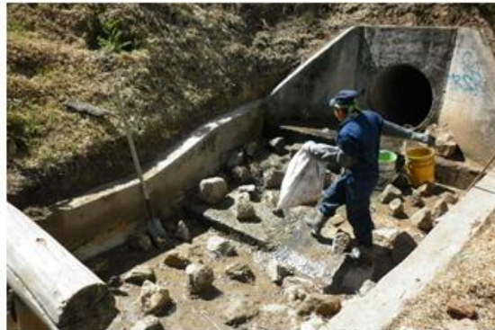
Recolección de residuos sólidos en canal
