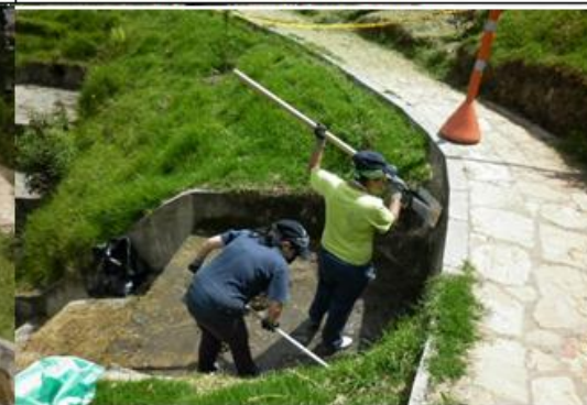
Operarios durante el proceso de mantenimiento
