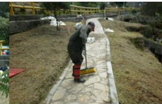
Limpieza de desechos vegetales por poda
