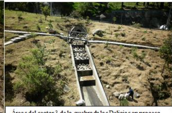
Áreas del sector 3 de la quebrada las Delicias en proceso de mantenimiento
