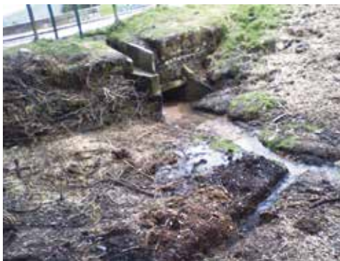
Apertura de canales laterales para mejoramiento de drenaje
