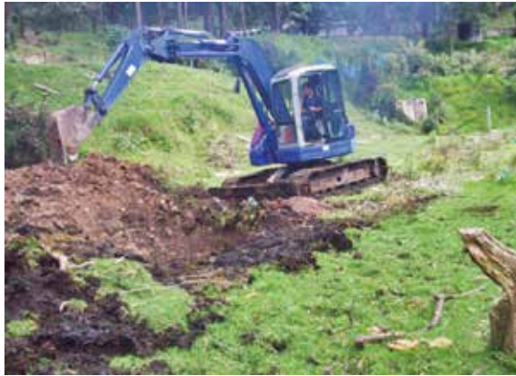
Figura 3.8 Lugar de depósito de retamo. Hueco con capacidad de almacenamiento de 250 m 3 de retamo.
