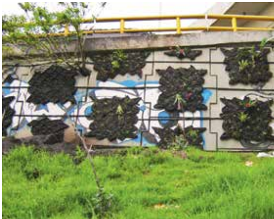
Figura 3.20b. Muro con módulos de tierra coloidal con plántulas y sin plántulas y con bolsillos de geotextil (año 2011)
