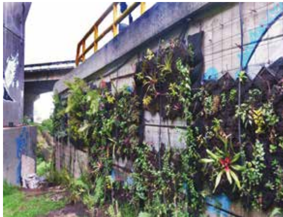
Figura 3.20b. Muro con módulos de tierra coloidal con plántulas y sin plántulas y con bolsillos de geotextil (año 2011)
