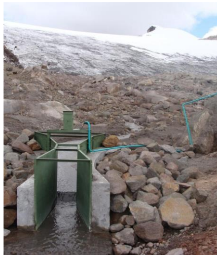
Figura 30. Canaleta Parshall para medición de caudal en pequeñas corrientes
