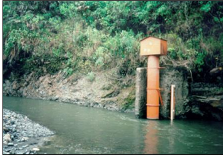
Figura 10. Instalación de tubos conductores al agua del río
